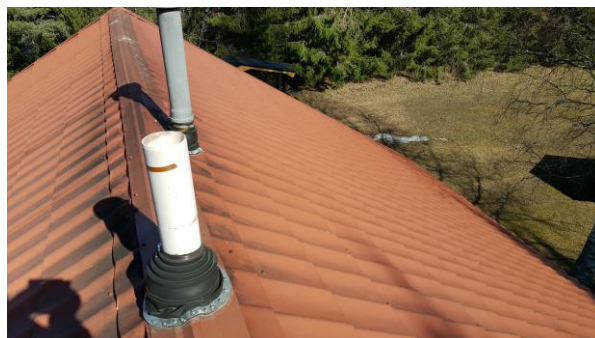
12. Läpivienteinä ilmanvaihtoputki ja viemärin tuuletusputki
