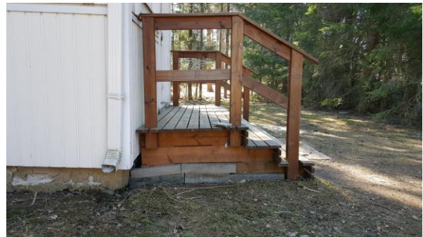
2. Rakennuksen sisääntulorappuset ovat hyväkuntoiset
