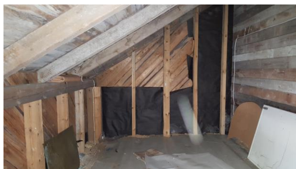
14. Sivunkaisten päihin tulisi asentaa ilmanvaihtoventtiilit.
