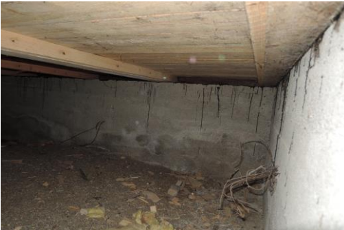
26. Alapohjan ryömintätila on normaali- kuntoisen oloinen.
