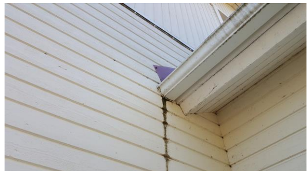
8. Sadevesikourun tulisi alkaa 20-30mm päästä ulkoverhouksen pinnasta.
