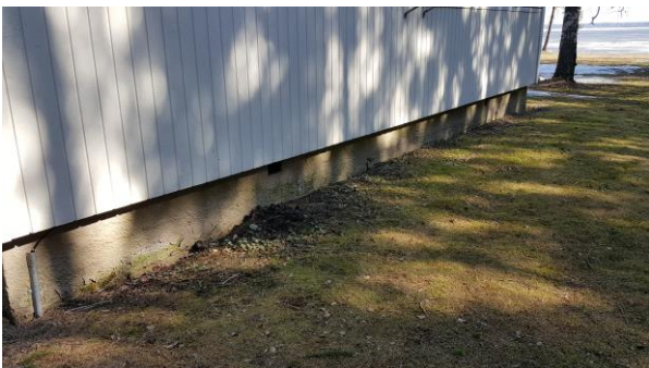
7. Sokkeli on betonirakenteinen ja maalattu.
