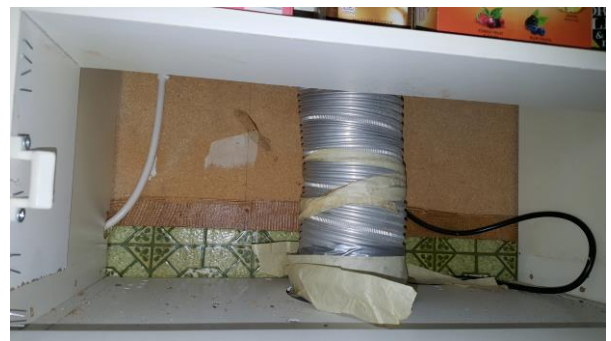
22. Liesituulettimen putken tulisi olla kierresaumapeltiä
