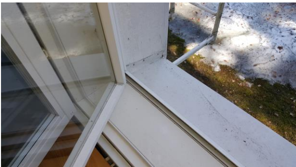
3. Ikkunat ovat hyväkuntoisia.
