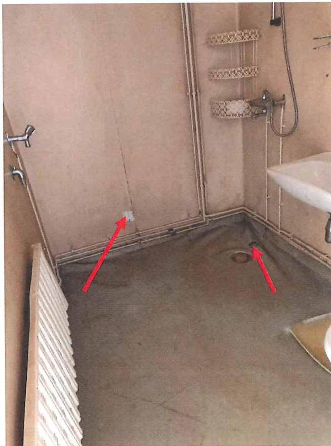
Kuva 5. Näyte 2 seinäkate ja tasoite, näyte 3 muovimatto
